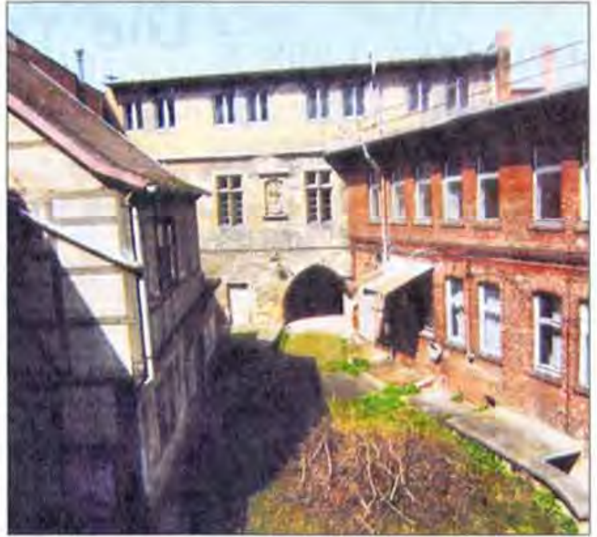
Fotos: Eberhard Menzel So sah das Gebäude vor der Sanierung aus, die jetzt zum Abschluss kommt.
