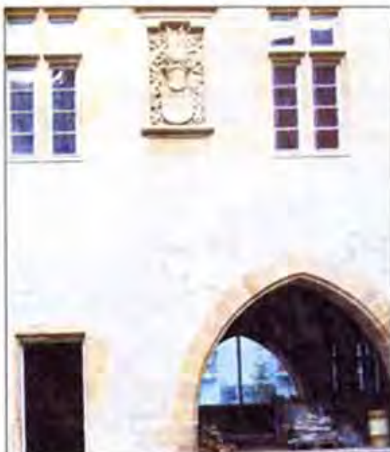
Johannes Kelters Steinhaus mit „Niederlage“ im Erdgeschoss.
