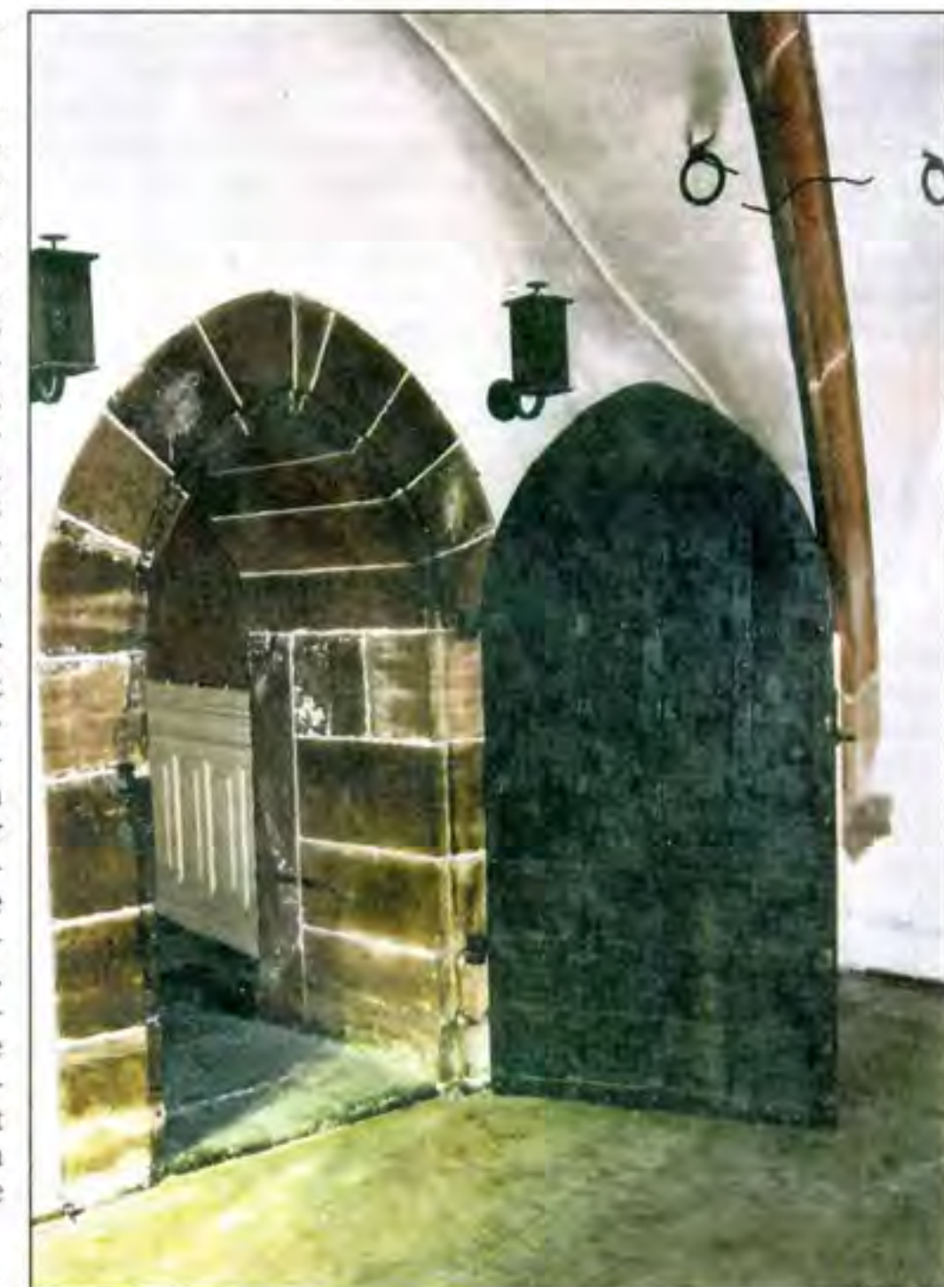
Das gotische Spitzbogenportal im Gewölberaum: Eine alte schmiedeiserne Tür ist erhalten geblieben.
