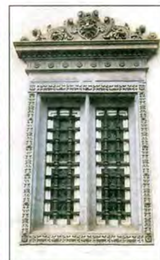
Äußere Stabvergitterung des Butzenscheibenfensters.
