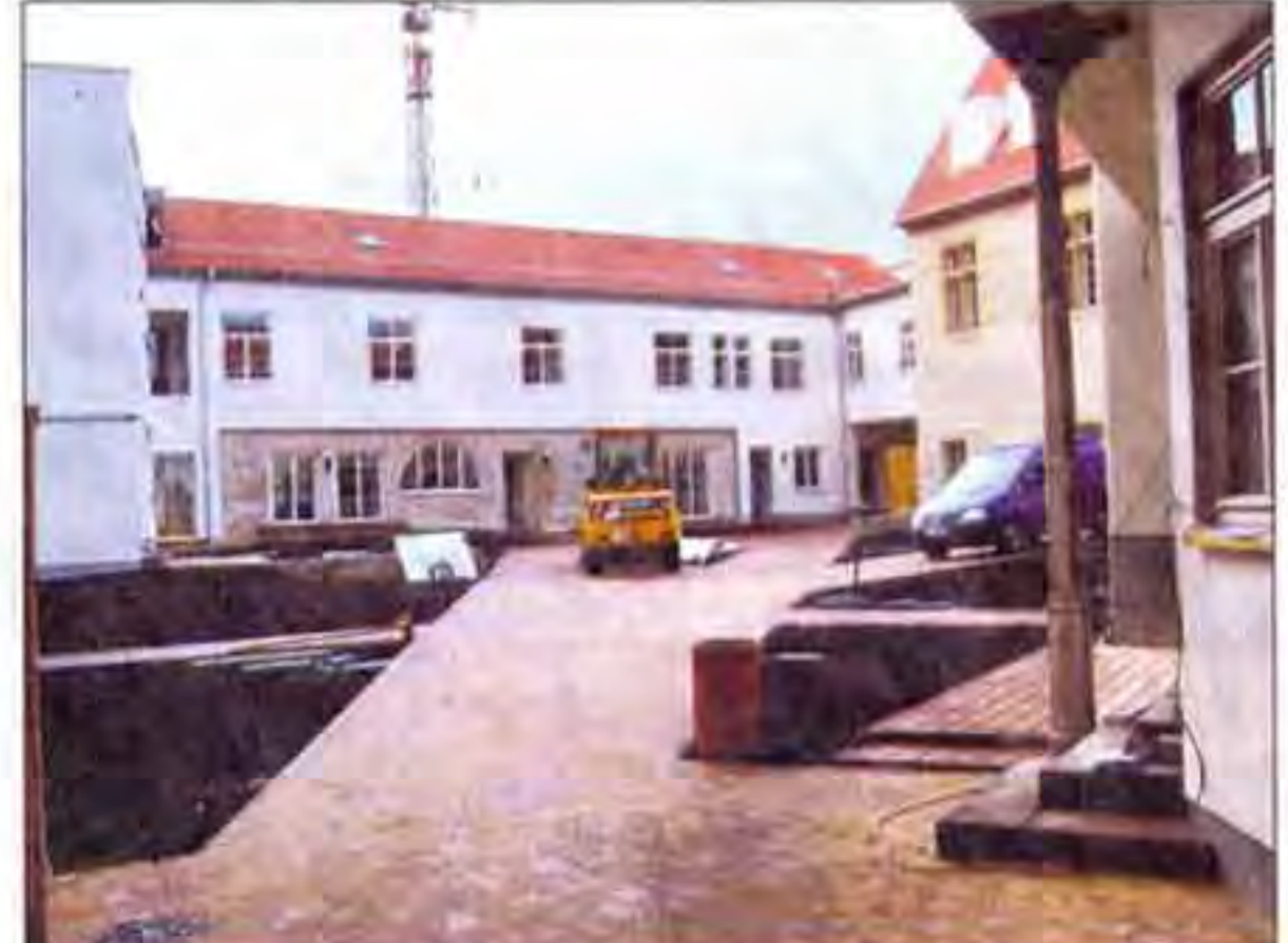
Blick in den Innenhof des Gebäudes an der Regierungsstraße 63/64.
