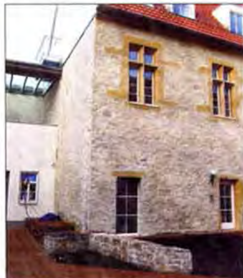
Der wiederhergestellte Teil am Großen Steinhaus.
